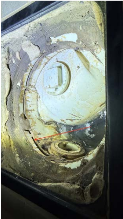
Eksempelbilde av glippe mellom klemring og sluk.
