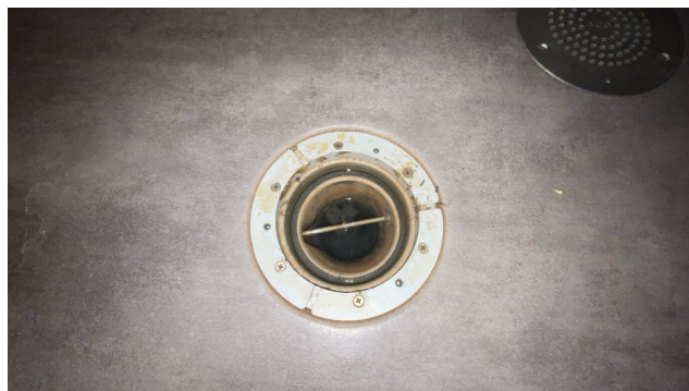
Kontroll av sluk.
