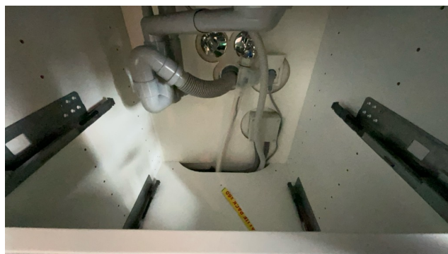
Besiktigelse av røropplegg.
