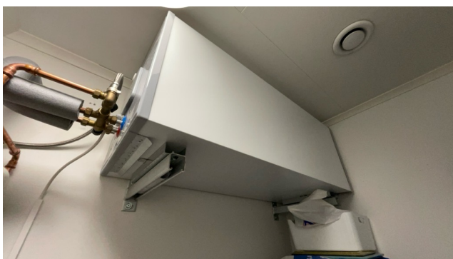
Besiktigelse av bereder.
