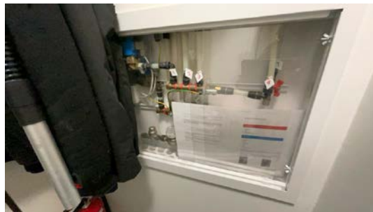
Besiktigelse av røropplegg.
