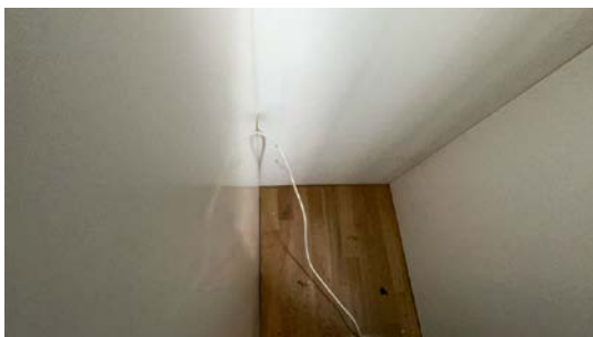
Kontroll bak kjøleskap. Ingen tegn til fuktskader på befaringdagen.
