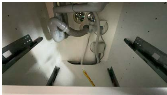
Besiktigelse av røropplegg.
