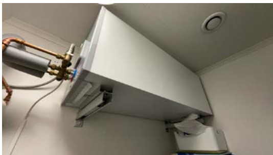
Besiktigelse av bereder.
