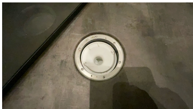
Kontroll av sluk.
