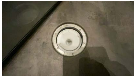
Kontroll av sluk.
