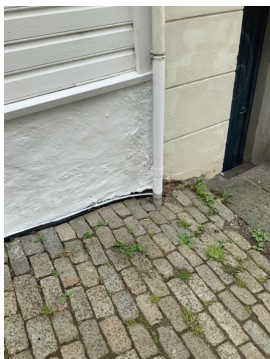
Takrenner og nedløp i plast. Takvann blir ledet under grunnen, antatt inn på kommunalt avløpsnett.
