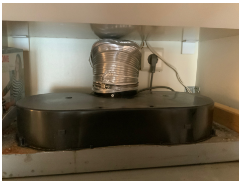
Avtrekk i yttervegg..
