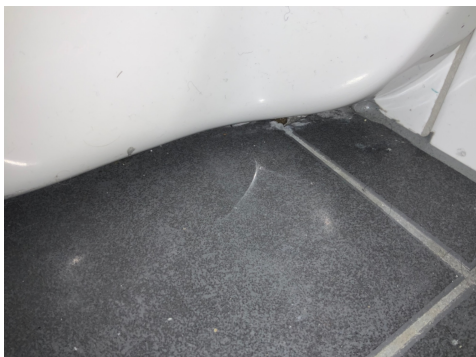
Vegghengt toalett er montert ned i/ under keramisk gulvflis.
