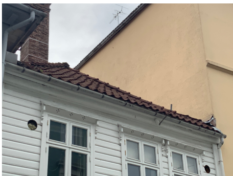
Yttertak er tekket med betongtakstein.
