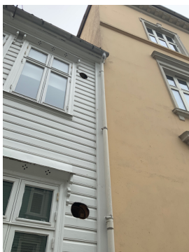
Takrenner og nedløp i plast. Takvann blir ledet under grunnen, antatt inn på kommunalt avløpsnett.
