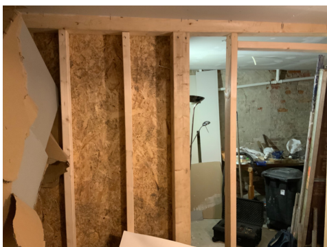
Påbegynte vegger/ stenderverk.
