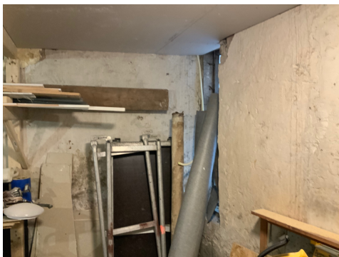
Kjellerrom med betongvegger.
