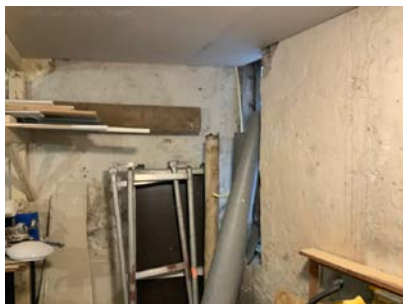
Kjellerrom med betongvegger.
