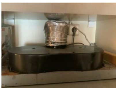
Avtrekk i yttervegg..
