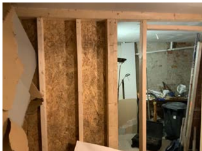
Påbegynte vegger/ stenderverk.
