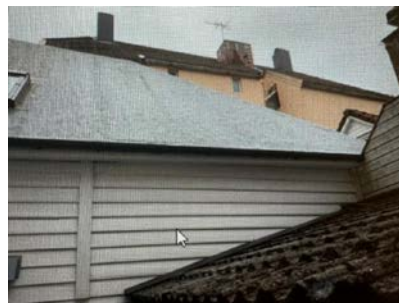
Yttertak i bakbygg er teknet med takpapp (protanduk).
