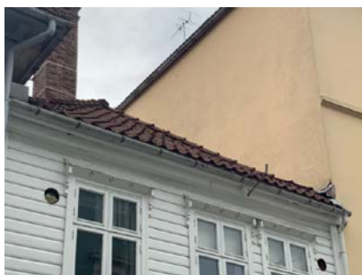
Yttertak er teknet med betongtakstein.
