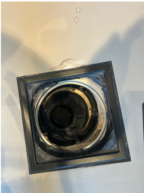
Sluk på bad i 2.etasje.
