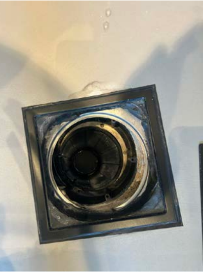
Sluk på bad i 2.etasje.
