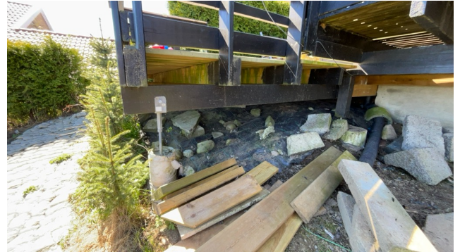
Kontroll av fundament.
