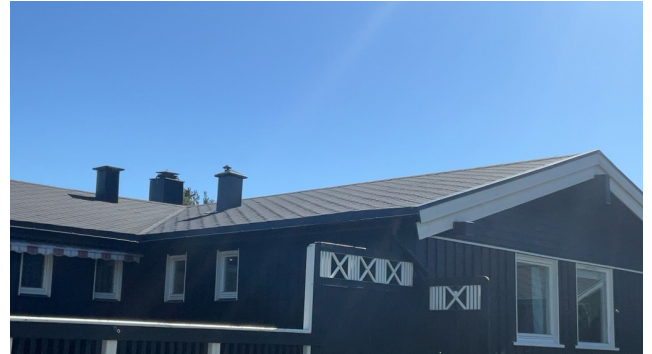
Besiktigelse av taktekke.
