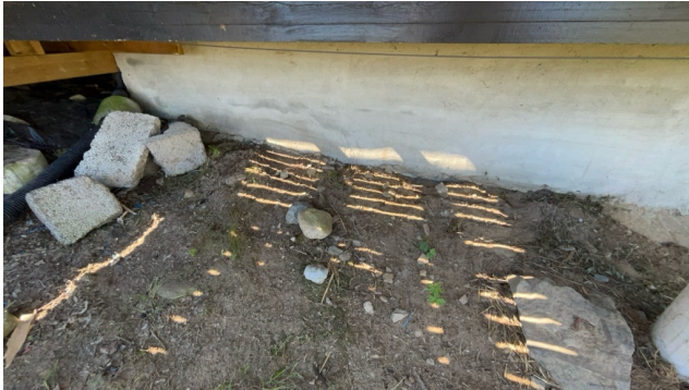
Kontroll av drenering/fuktsikring.
