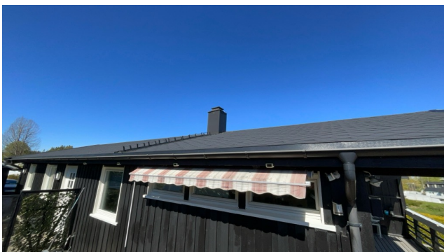
Besiktigelse av taktekke.
