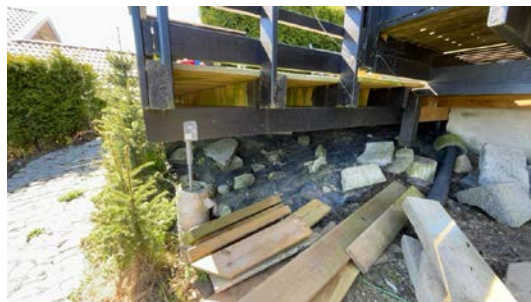
Kontroll av fundament.
