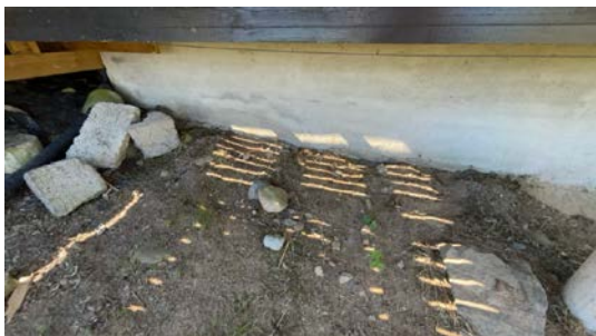
Kontroll av drenering/fuktsikring.
