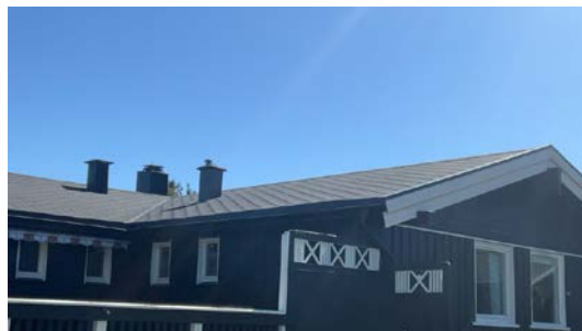
Besiktigelse av taktekke.
