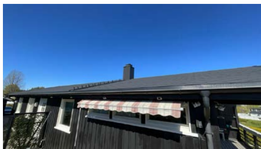
Besiktigelse av taktekke.
