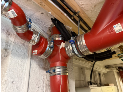
Nyere ma støpejernsrør i u-etg.
