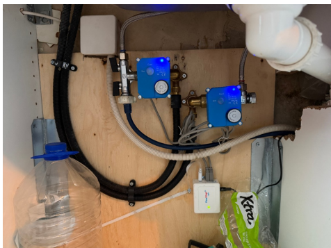
Rørøpplagg og aquastop under vask.
