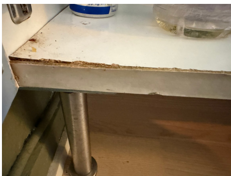
Fuktutsvelling i skapbunn under vask.
