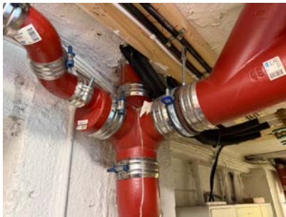
Nyere ma støpejernsrør i u-etg.
