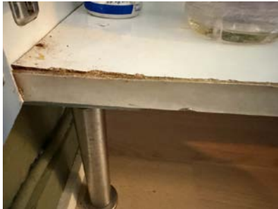
Fuktutsvelling i skapbunn under vask.
