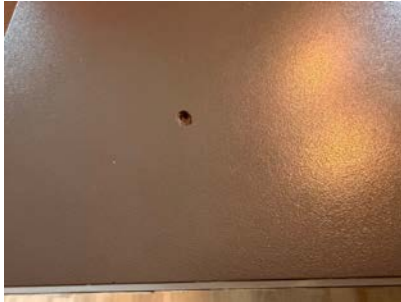
Hakk i benkeplate. 2-ETG > ENTRÉ/GANG/STUE/KJØKKEN (27,3 M²)
