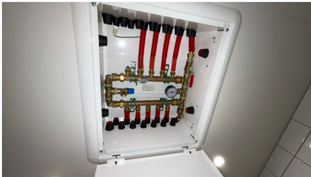
Besiktigelse av røropplegg.
