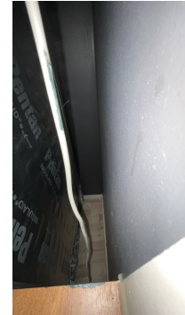
Kontroll bak kjøleskap. Ingen tegn til fuktskader på befaringsdagen.
