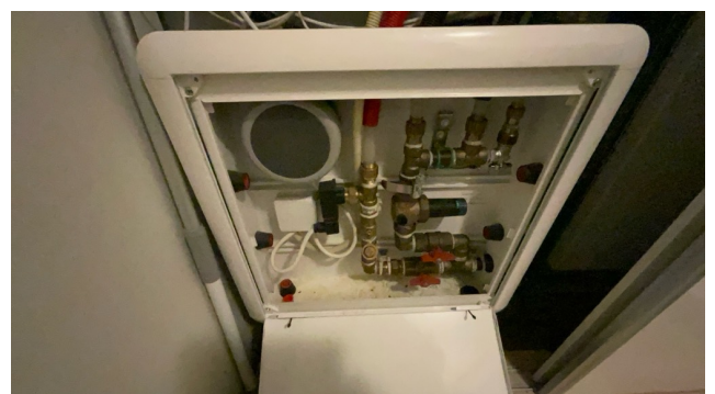
Besiktigelse av røropplegg.
