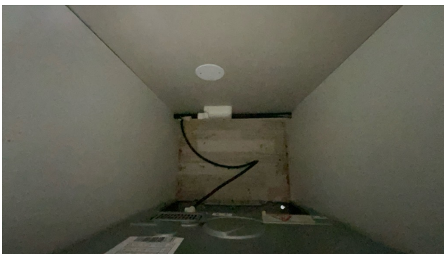
Kontroll bak ovn. Ingen tegn til fuktskader på befaringsdagen.
