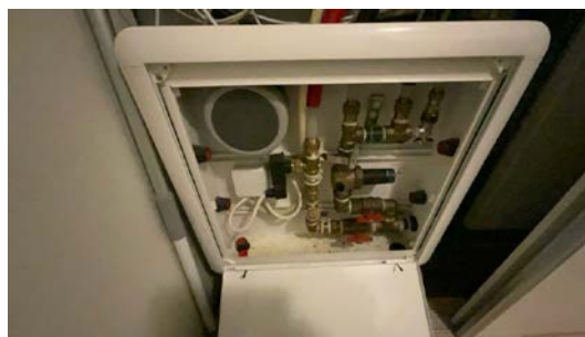
Besiktigelse av røropplegg.
