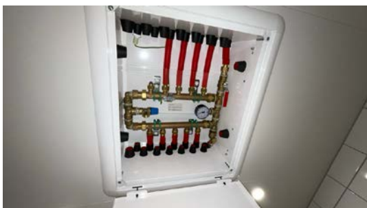
Besiktigelse av røropplegg.
