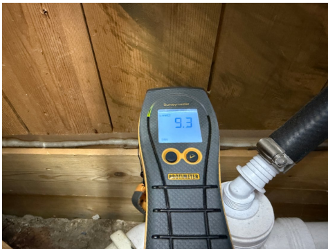
Måling av trefukt/vektprosent.
