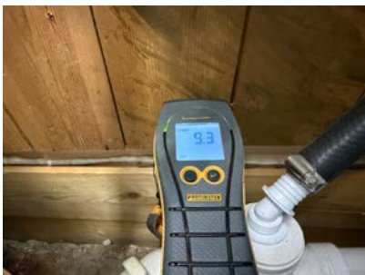
Måling av trefukt/vektprosent.
