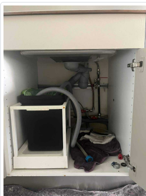
Oversiktsbilde av de-montert rørapplegg under vasken
