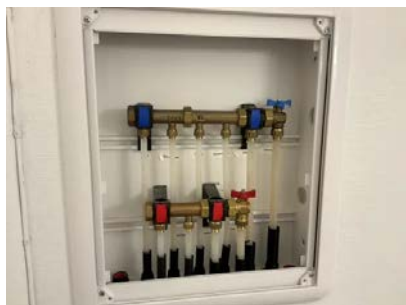
Fordelerskap til «rør i rør» vannforsyning
