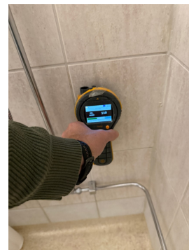
Ingen unormale utslag med fuktindikator på dusjvegger på befaringdagen
