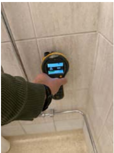
Ingen unormale utslag med fuktindikator på dusjvegger på befaringsdagen
