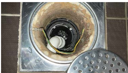
sluk, membran og tettesjikt
