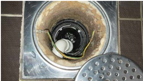
sluk, membran og tettesjikt
