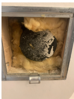
Stakeluke for avløpsrør plassert i entre
