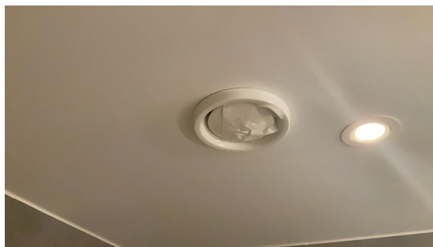
Test av avtrekk. Papiret henger.
