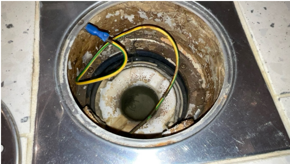
sluk, membran og tettesjikt
