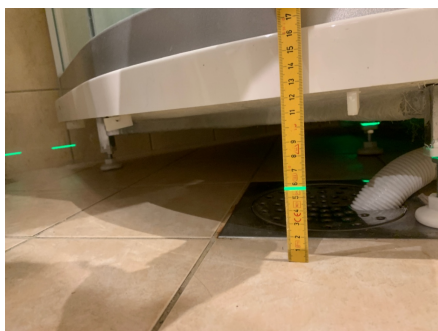
18 mm fall fra topp flis ved dør til topp flis ved terskel
