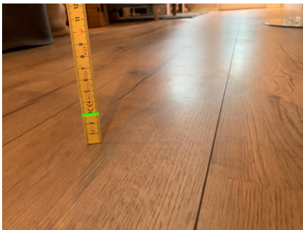
11mm retningsavvik på en lengde på 2 meter
