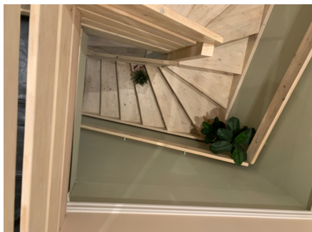
Tretrapp sett ovenfra
