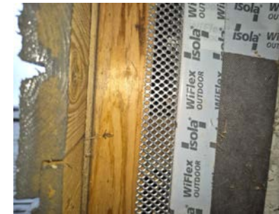
Påforde siporex-vegger ved opprinnelig bolig.
