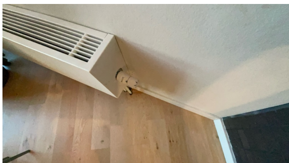
vannbårent varmeanlegg
