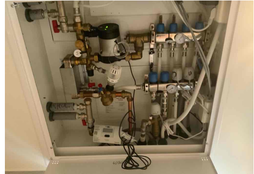
Besiktigelse av røropplegg.
