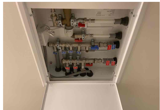
Besiktigelse av røropplegg.
