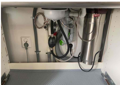
Besiktigelse av røropplegg.
