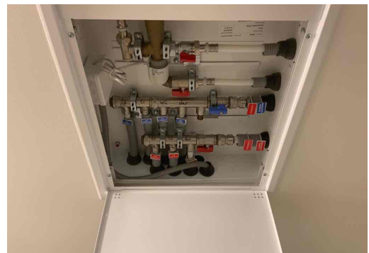
Besiktigelse av røropplegg.
