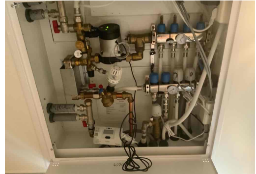
Besiktigelse av røropplegg.
