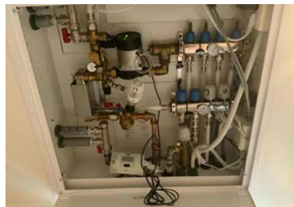
Besiktigelse av røropplegg.
