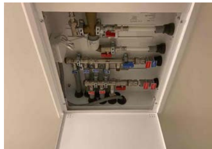
Besiktigelse av røropplegg.
