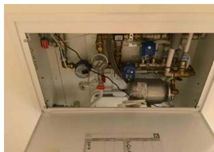
Besiktigelse av røropplegg.
