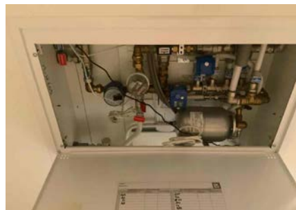
Besiktigelse av røropplegg.
