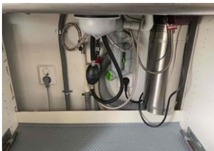
Besiktigelse av røropplegg.
