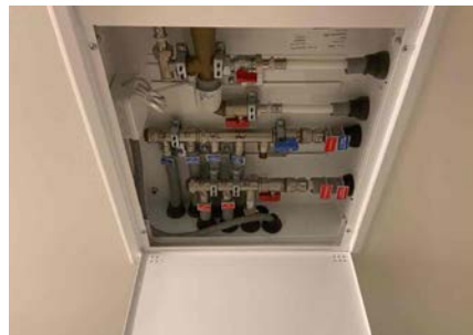
Besiktigelse av røropplegg.
