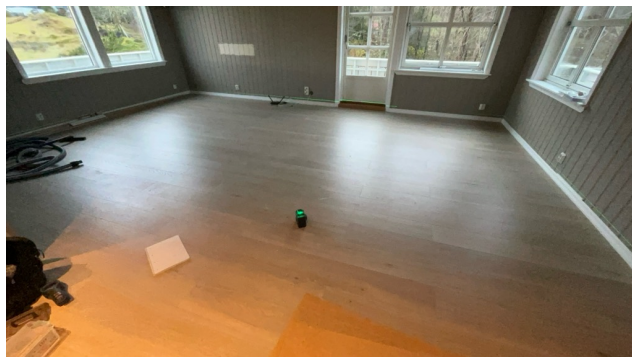
Måling av eventuelt retningsavvik
