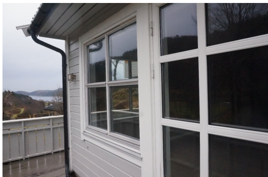
Vindu i tilbygg.
