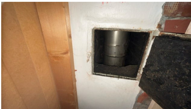
Stålrør i pipe.
