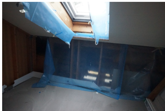
Ikke isolert vegg
