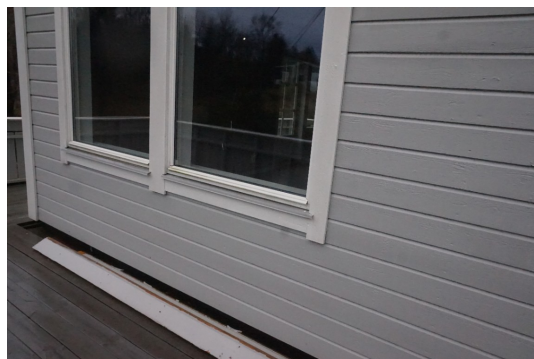
Vindu i tilbygg.
