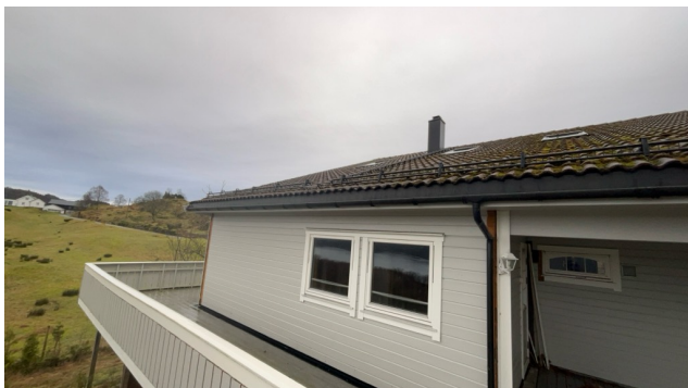
Takrenner, stigetrinn til pipe og snøfangere
