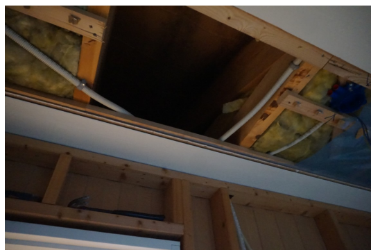
Ikke isolert himling.
