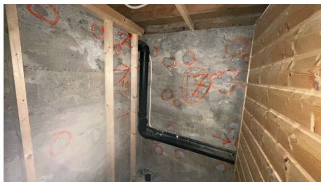
Yttervegger, merket der det har vært tettet hull.
