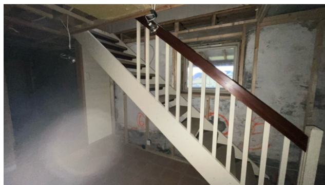
Åpning i rekkverket
