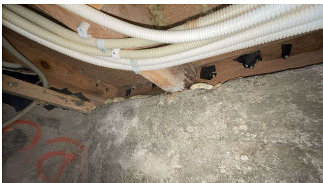
Fuktskadet trebjelke
