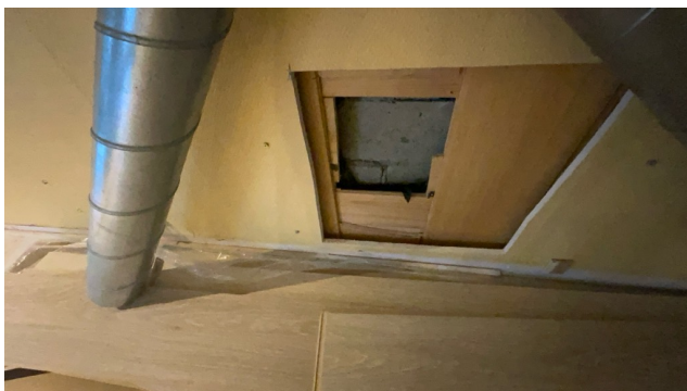
Yttervegg fra innsiden
