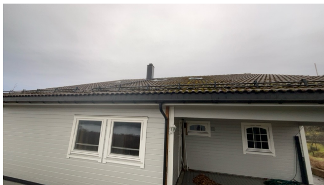
Takrenner, stigetrinn til pipe og snøfangere
