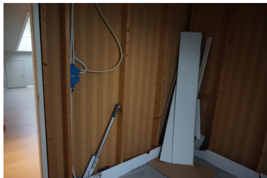
Vegger på fremtidig bad.
