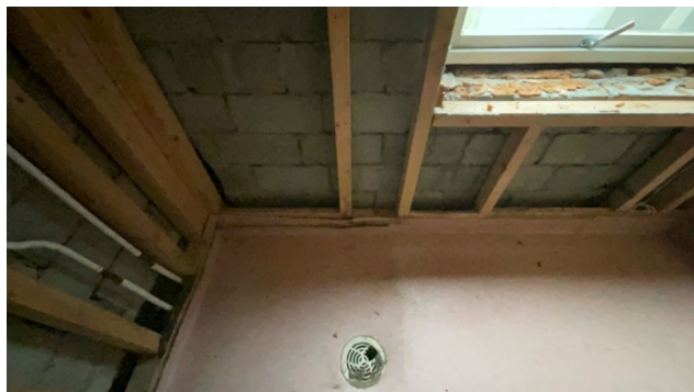
Bad, synlig vegg
