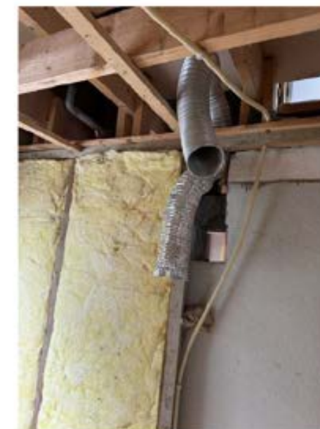
Ventilasjon fra 1.et. til kneloft, 2.stk.
