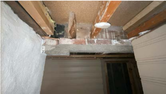
Svak understøttelse av bjelkelaget
