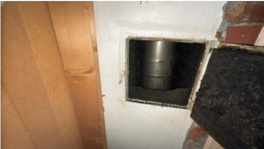
Stålrør i pipe.
