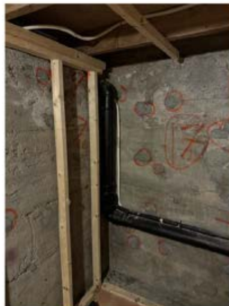
Stedvis eldre tettingsarbeid.
