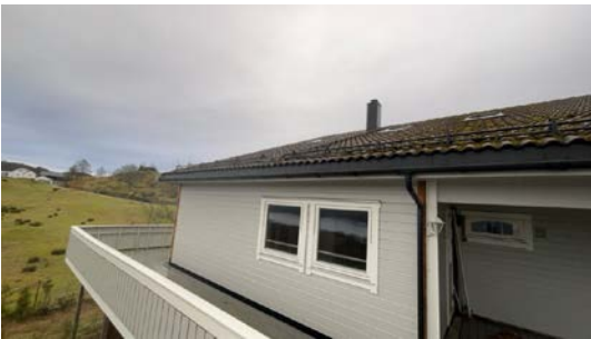
Takrenner, stigetrinn til pipe og snøfangere
