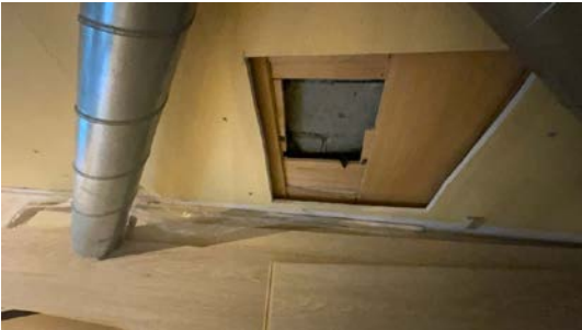
Yttervegg fra innsiden
