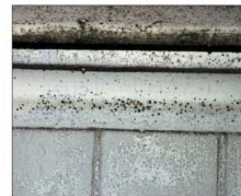
Svertesopp på hvitmalte panelbord.
