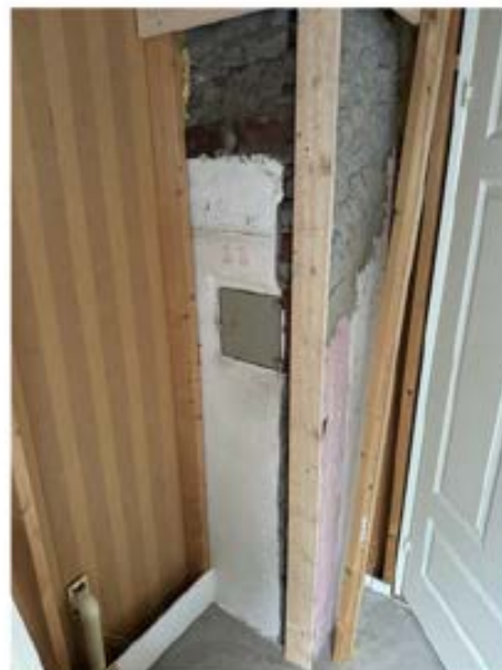
Påbegynt innkledning av pipe og sotluke
