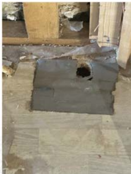
Åpning er tettet med tape.
