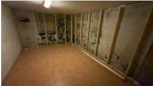
Vegger i bod.
