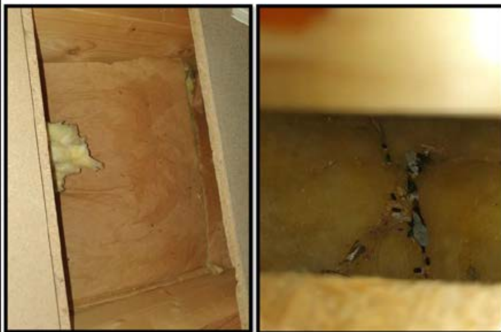
Isolasjon på loftet er fjernet / kontrollert delvis fra underside og delvis fra kneloft. Her var spor etter mus over hele 2.etg. Den isolasjon som ikke er egnet til gjenbruk er fjernet av oss.
