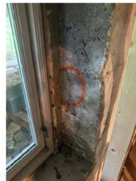
Oransje sirkel markerer tettingsarbeid utført av Rentox.
