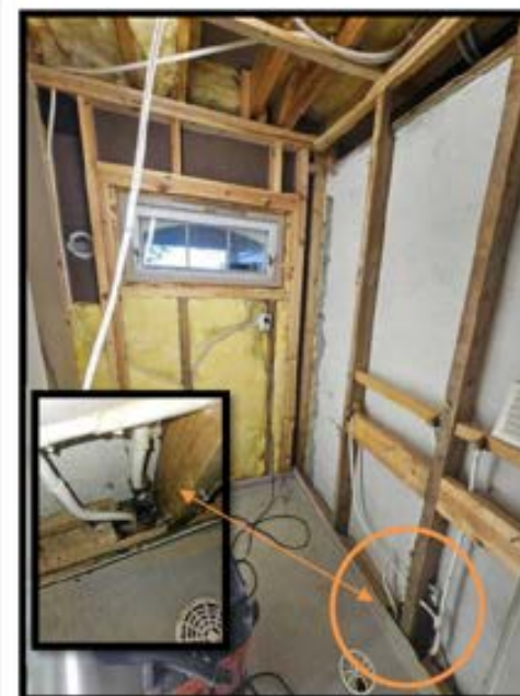
Viser forlengelse av eldre grunnmur. Her var spor etter mus i utforingsvegg + himling. Veggventil er montert feil. Det er også gnagd på isolasjon rundt vannrør.
