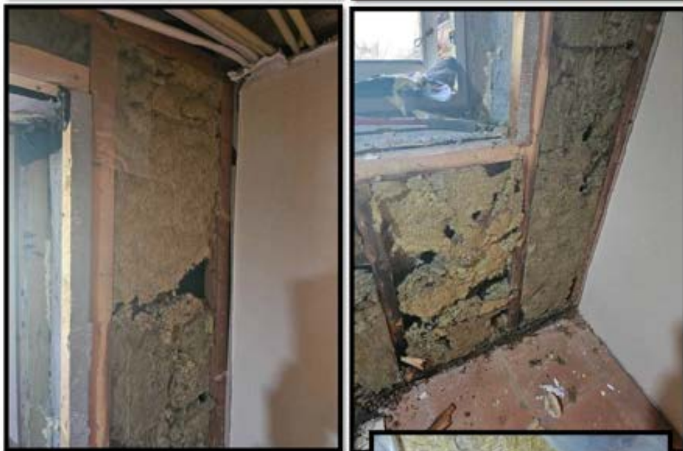
Store ødeleggelser i veggen mellom biovac og trapperom.
