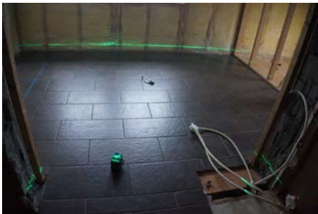
Overflater på vegger er fjernet
