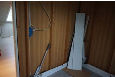
Vegger på fremtidig bad.
