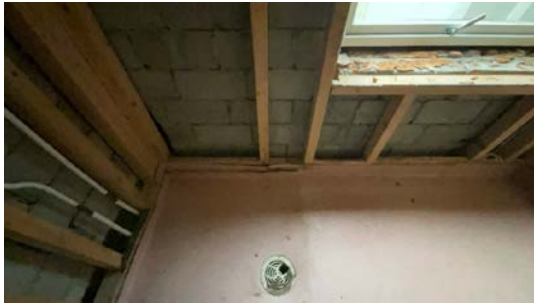
Bad, synlig vegg
