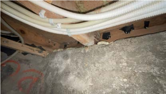
Fuktskadet trebjelke
