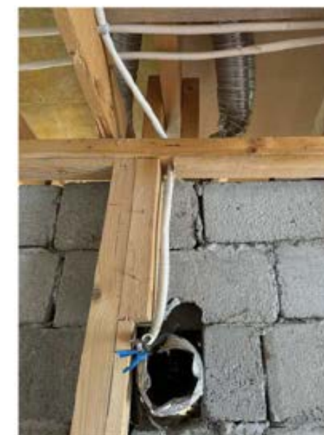
Kanal i innvendig skillevegg til kneloft.
