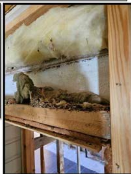
Bildene viser noe isolasjonsrester + museavføring og masse nøtter. Dette har musene lagret inne i himling og i utforingsvegg.
