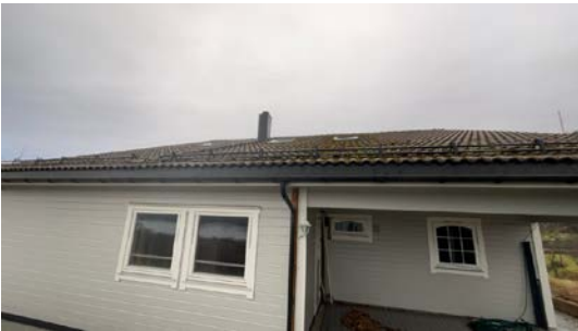
Takrenner, stigetrinn til pipe og snøfangere
