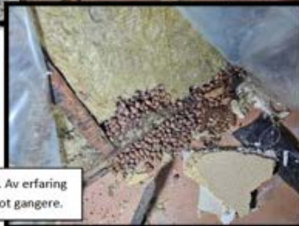
Store ødeleggelser i veggen mellom biovac og trapperom.
