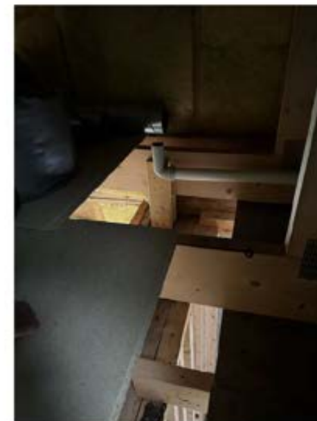
Lufting avløp!
