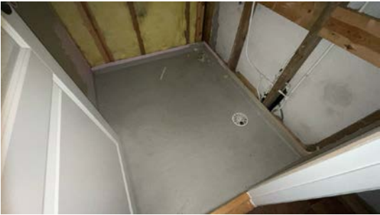
Gulv på vaskerom
