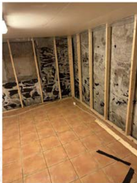
Demonterte vegger i blindkjeller.
