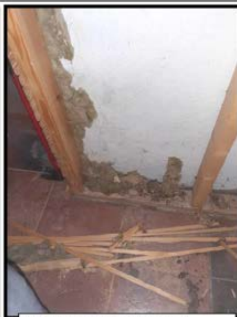
Bildene viser noe isolasjonsrester + museavføring og masse nøtter. Dette har musene lagret inne i himling og i utforingsvegg.
