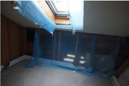
Ikke isolert vegg
