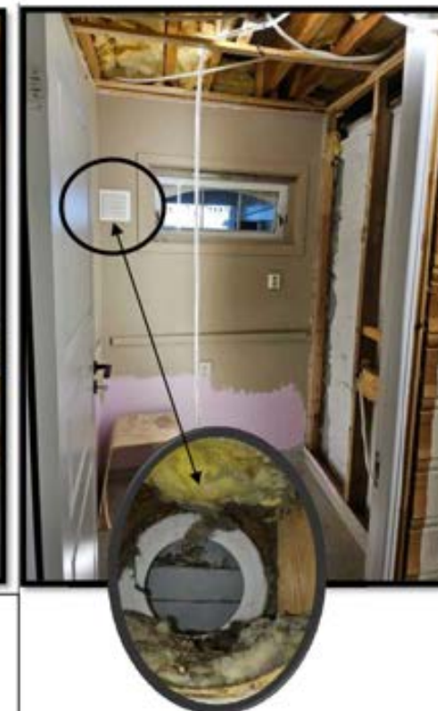
Viser forlengelse av eldre grunnmur. Her var spor etter mus i utforingsvegg + himling. Veggventil er montert feil. Det er også gnagd på isolasjon rundt vannrør.
