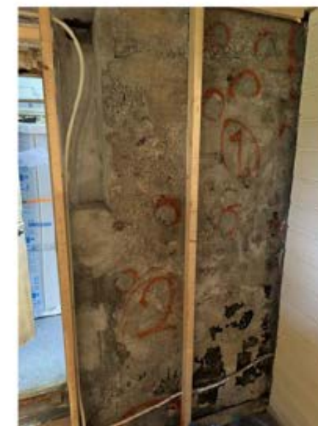
Omfattende tettingsarbeid er utført.
