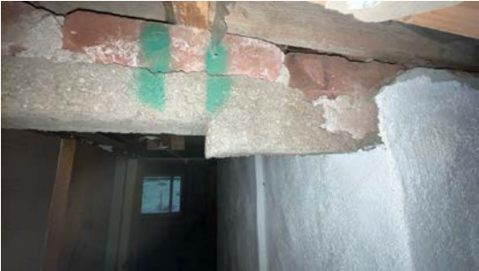
Svak understøttelse av bjelkelaget
