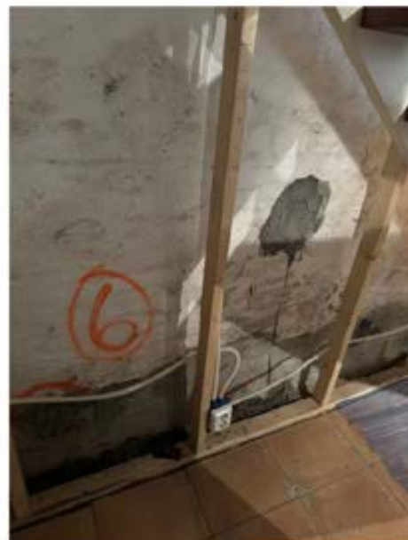
1 eldre tettingsarbeid.
