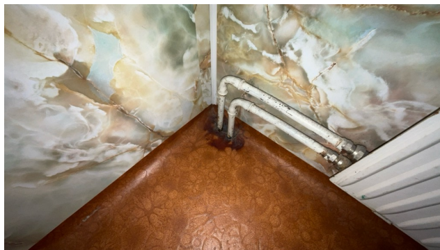
Utette rørgjennomganger.
