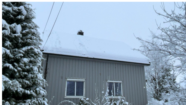
Besiktigelse av taktekke.
