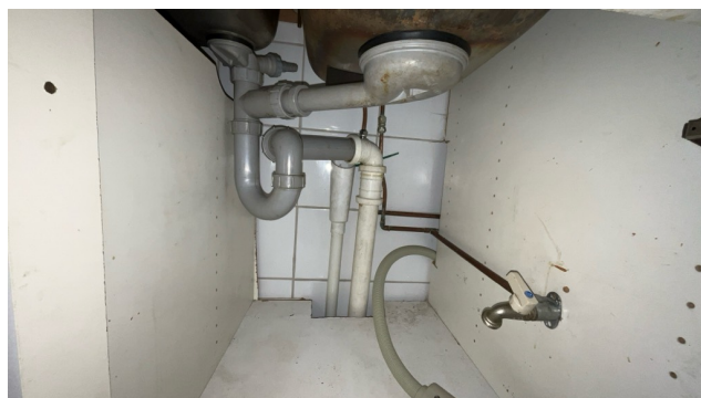
Besiktigelse av rørøpplagg.
