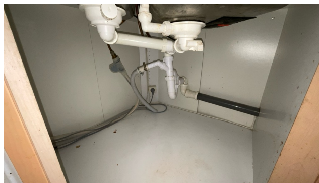
Besiktigelse av rørøpplagg.
