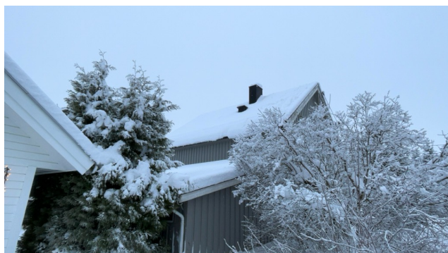
Besiktigelse av taktekke.
