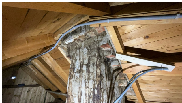
Kontroll rundt pipeløp.
