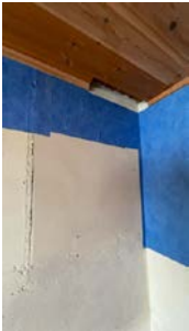
Synlig tegn til at pipeløp svetter ved fyring og er noe utett.
