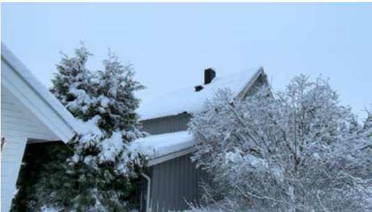
Besiktigelse av taktekke.
