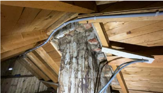
Kontroll rundt pipeløp.
