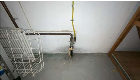
Besiktigelse av røropplegg.
