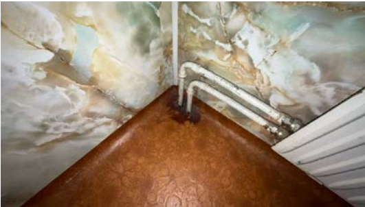
Utette rørgjennomganger.
