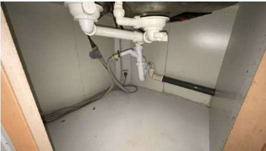
Besiktigelse av røropplegg.
