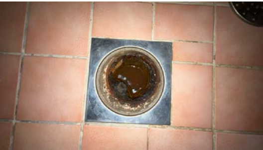
Kontroll av sluk.
