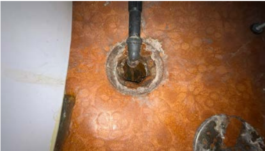
Kontroll av sluk.
