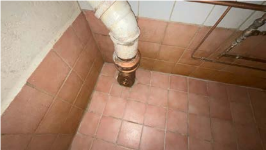
Utette rørgjennomføringer.
