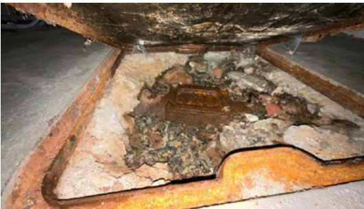
Synlige rustskader.
