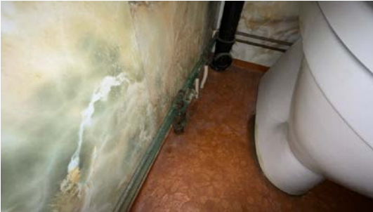
Utette rørgjennomganger.
