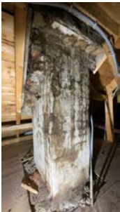
Synlig tegn til at pipeløp svetter ved fyring og er noe utett.
