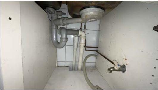
Besiktigelse av røropplegg.
