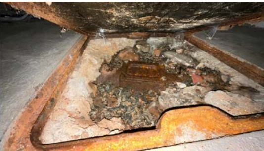
Synlige rustskader.
