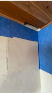
Synlig tegn til at pipeløp svetter ved fyring og er noe utett.
