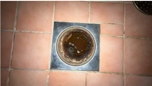
Kontroll av sluk.
