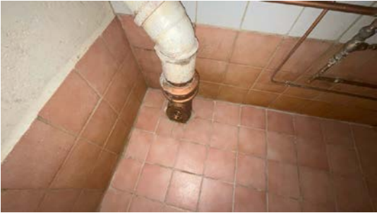
Utette rørgjennomføringer.
