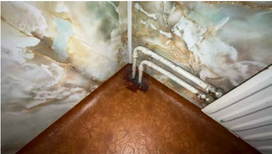
Utette rørgjennomganger.
