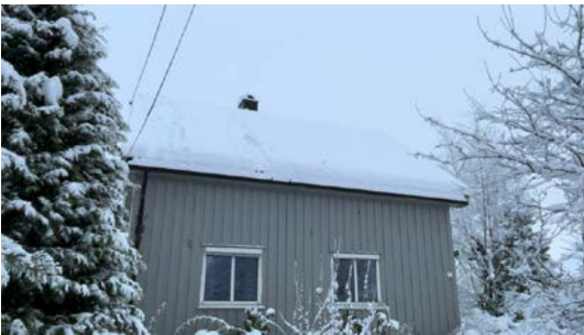
Besiktigelse av taktekke.
