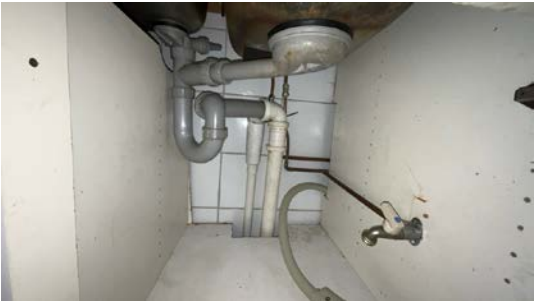
Besiktigelse av røropplegg.
