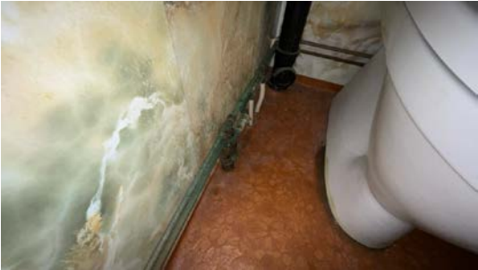
Utette rørgjennomganger.
