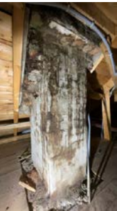
Synlig tegn til at pipeløp svetter ved fyring og er noe utett.
