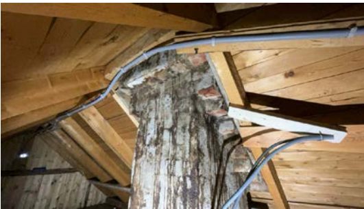
Kontroll rundt pipeløp.
