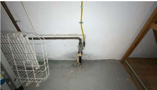
Besiktigelse av røropplegg.
