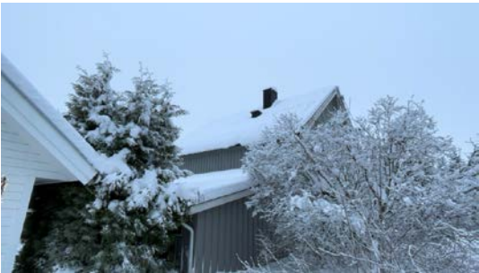
Besiktigelse av taktekke.
