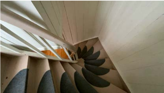
Besiktigelse av trapp.
