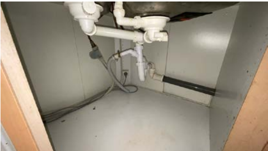
Besiktigelse av røropplegg.
