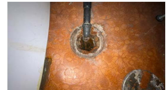
Kontroll av sluk.
