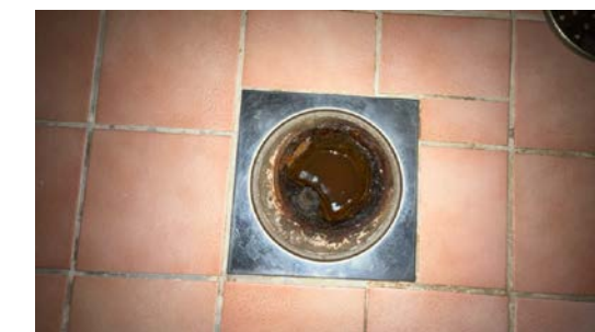
Kontroll av sluk.
