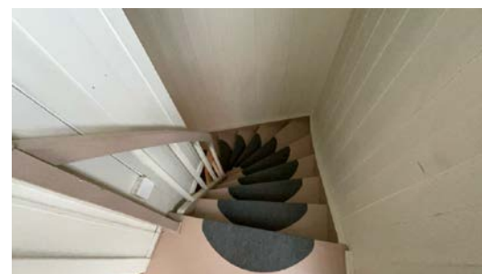
Besiktigelse av trapp.
