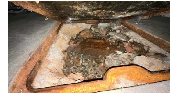
Synlige rustskader.
