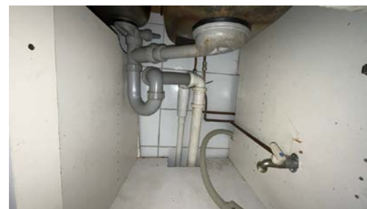
Besiktigelse av røropplegg.
