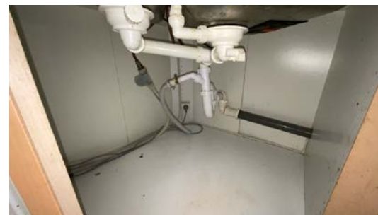
Besiktigelse av røropplegg.
