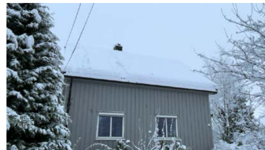
Besiktigelse av taktekke.
