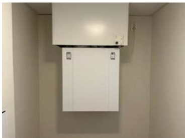
Ventilasjonsaggregat
