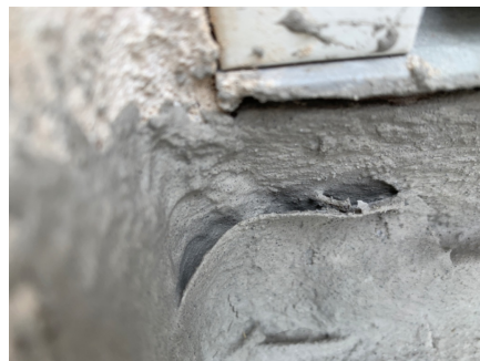
Små gliper på membran ved overganger
