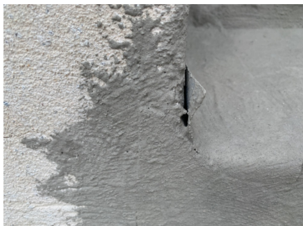
Små gliper på membran ved overganger
