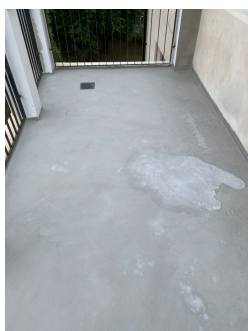
Små gliper på membran ved overganger
