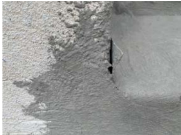
Små gliper på membran ved overganger
