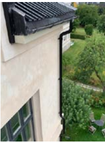
Eldre renner. Nyere nedløpsrør.
