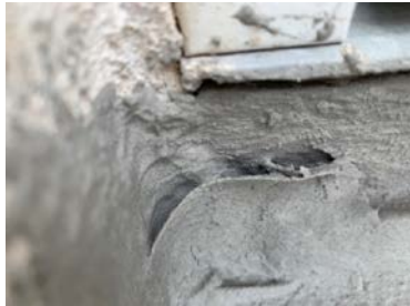
Små gliper på membran ved overganger
