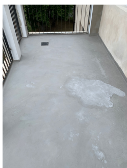
Små gliper på membran ved overganger
