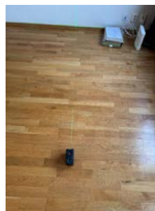
Foto viser nivellering med krysslaser i stue
