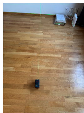
Foto viser nivellering med krysslaser i stue
