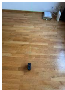
Foto viser nivellering med krysslaser i stue
