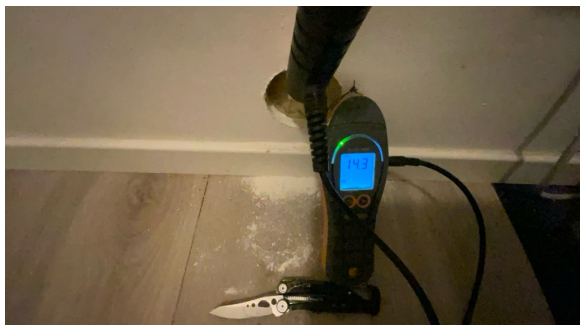
Fuktsøk i vegg med hulltaking
