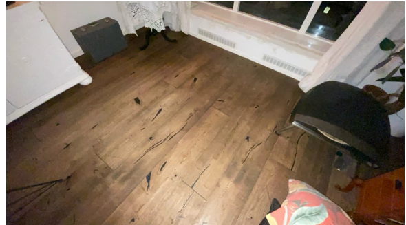
overflater i 2.etg
