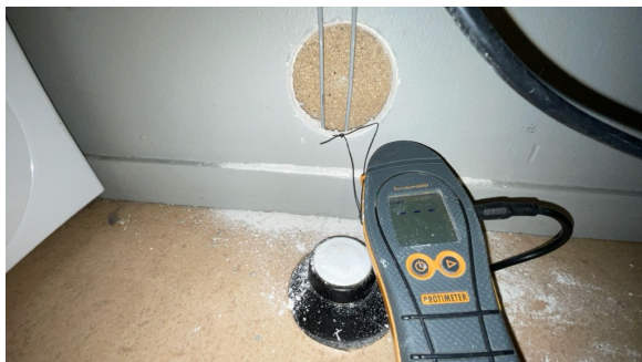
Hulltagning og fuktsøk
