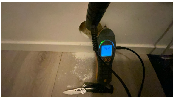
Fuktsøk i vegg med hulltaking
