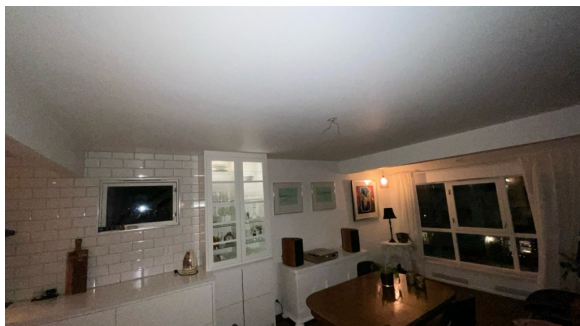
overflater i 2.etg
