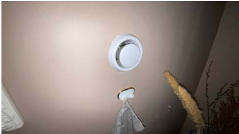
WC i loftetasje
