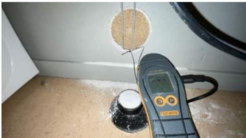
Hulltagning og fuktsøk
