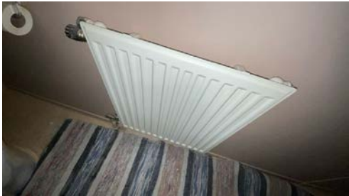
vannbårent varmeanlegg
