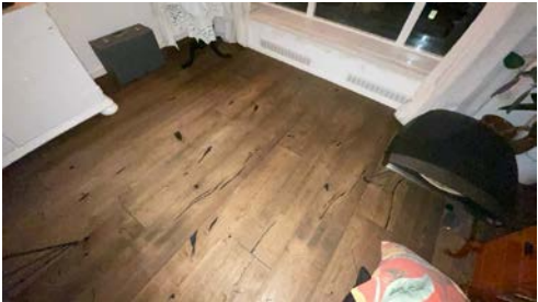
overflater i 2.etg
