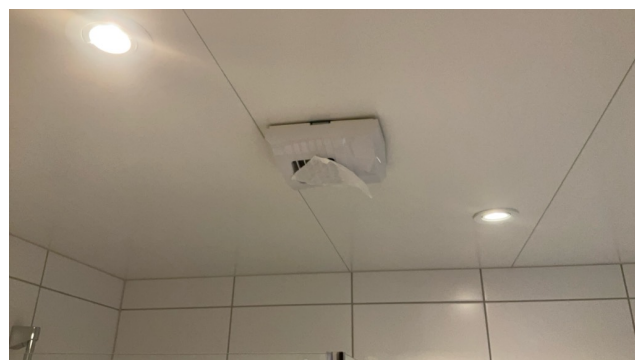
Test av avtrekk.
